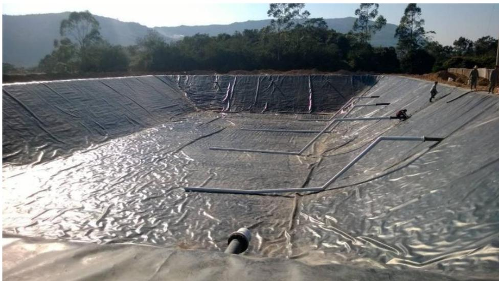
图2.7-6 黑膜沼气池内部示意图（仅供参考，非本项目）
